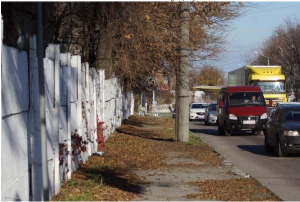
Ділянка з парканом по периметру території(Д9)
